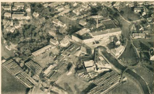
Leinfelder'sche Papier- und Cellulosefabrik in der Oberen Vorstadt
